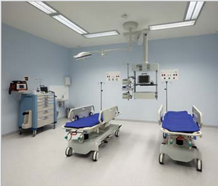
Solução com 3 níveis para painéis técnicos encastráveis para salas de cirurgia. Solution with 3 levels for operating rooms with recessed technical panels.
