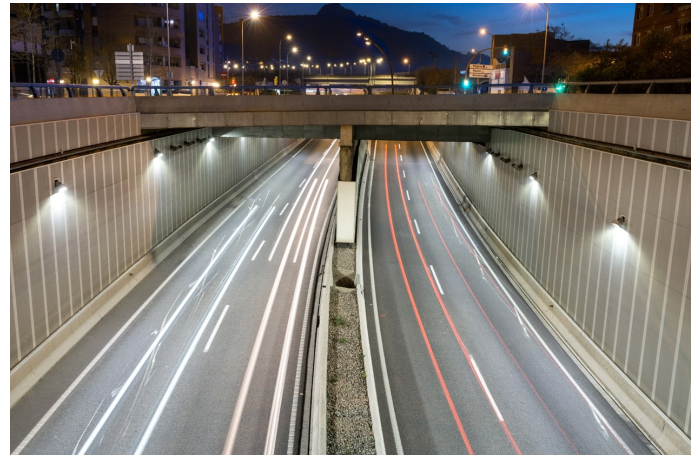
C-17 Tunnel Montcada y Reixac, Barcelona - Spain
